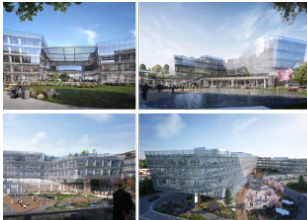
Figura 2 HUBTOWN - Vista degli edifici A , B, C1, C2
